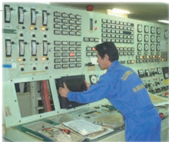
アラーム & モニタリングシステムの換装工事 (機関制御室内)
