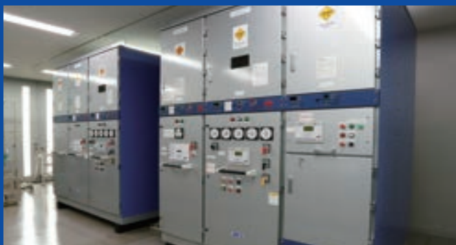
高圧配電盤シミュレータ
