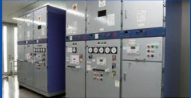
高圧配電盤シミュレータ
