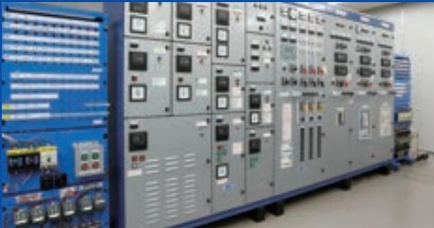
低圧配電盤・始動器盤シミュレータ
